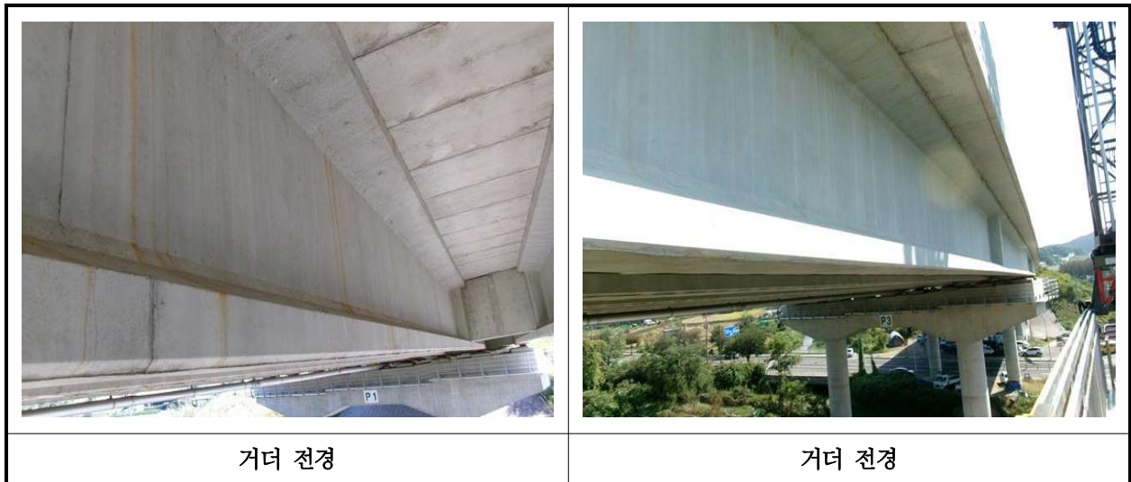
【사진 36.3.4】 거더 전경
