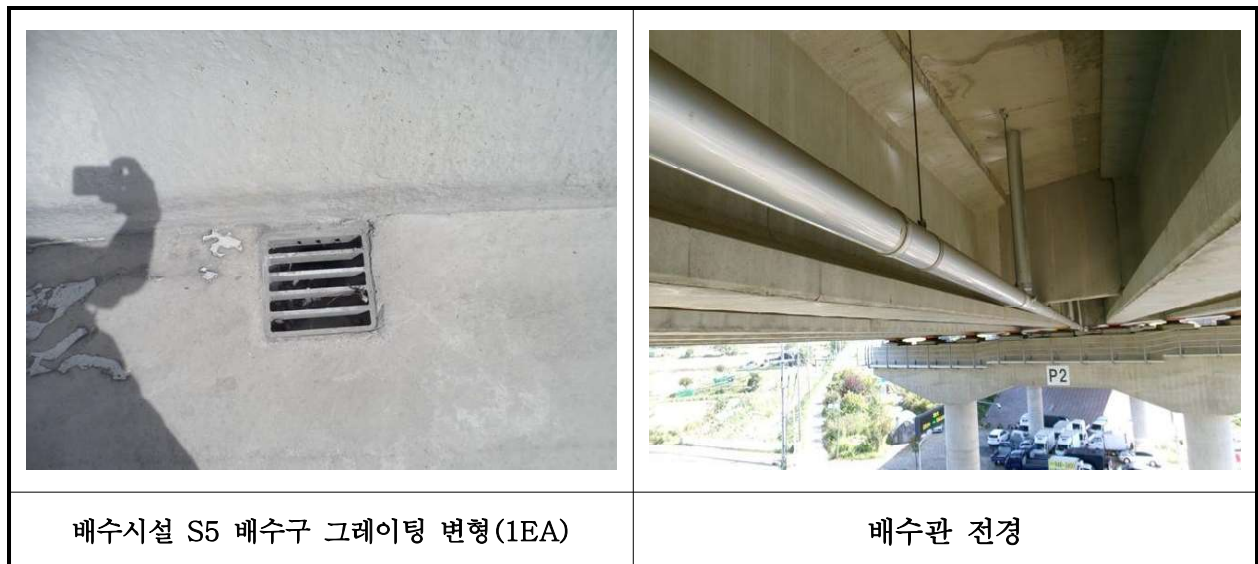
【사진 36.3.21】 배수시설 전경
