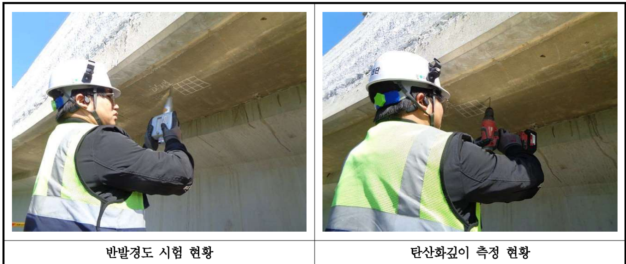
【사진 36.4.1】 콘크리트 내구성조사 현황
