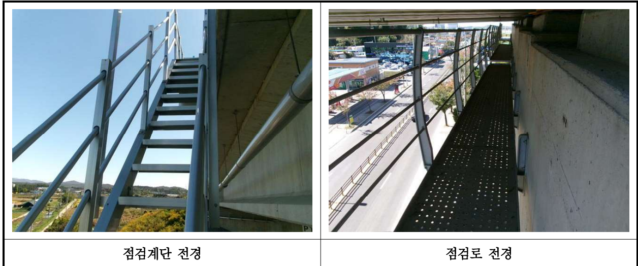
【사진 36.3.25】 교량 점검시설 전경
