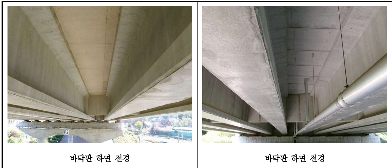
【사진 36.3.2】 바닥판하면 전경
