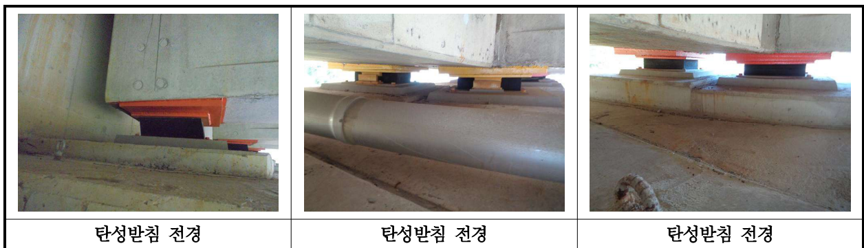
【사진 36.3.12】 교량받침 전경
