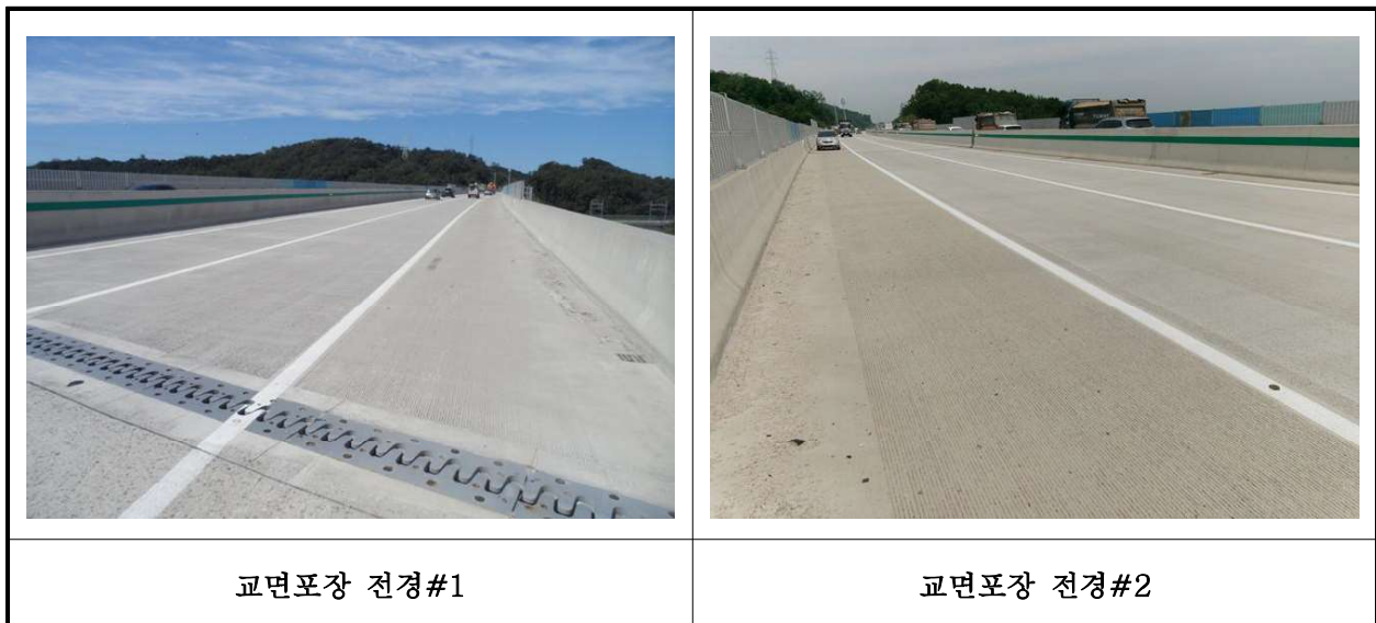
【사진 36.3.19】 교면포장 전경
