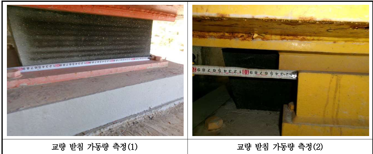
【사진 36.3.15】 교량받침 이동량 측정
