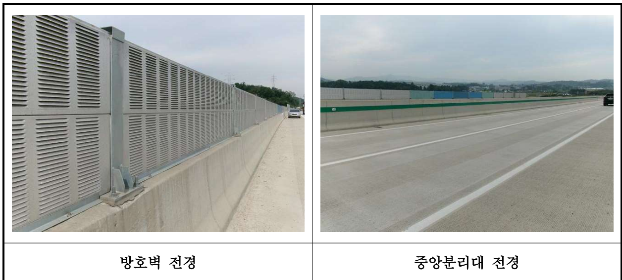
【사진 36.3.23】 방호벽 및 중앙분리대 전경
